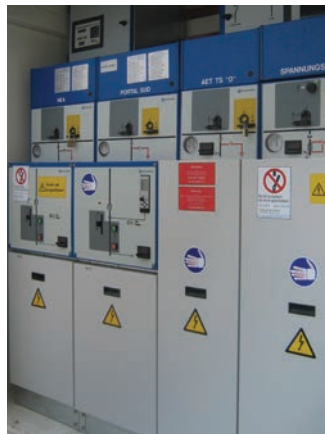
Tunelul Gotthard (Elveția)
